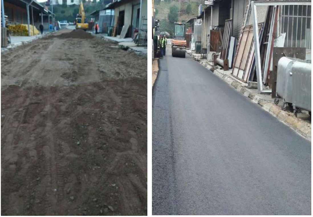
Karapınar Mahallesi 1155 Nolu Sokak Asfaltlama İşi İlk/Son Hali
