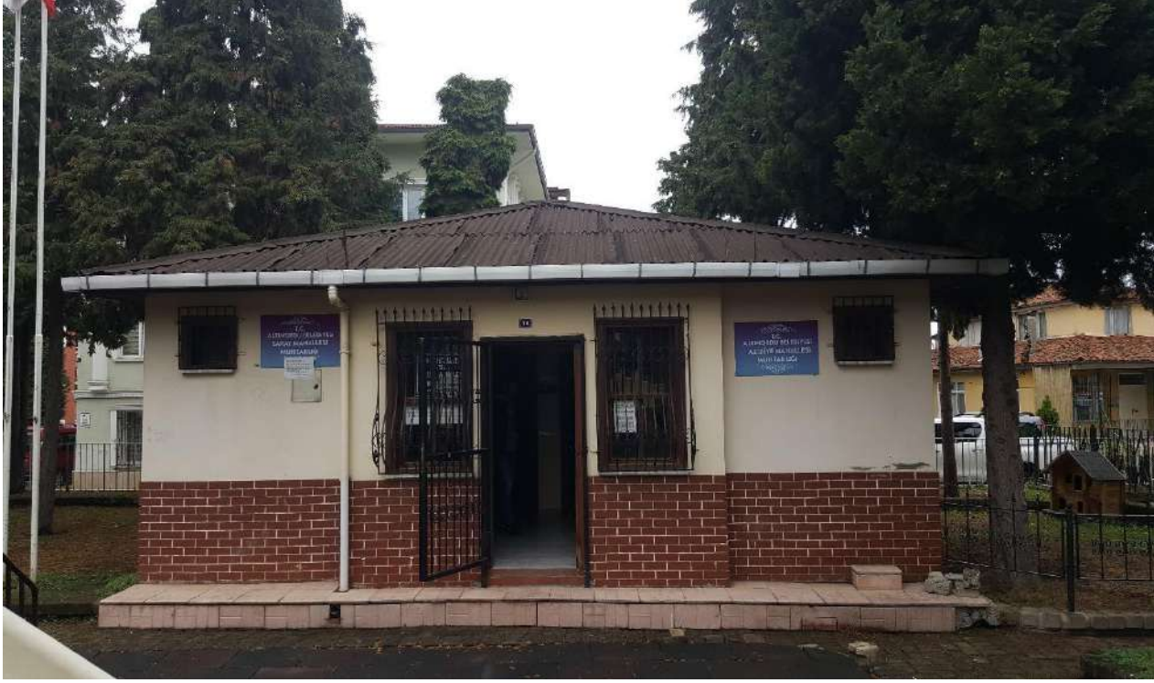
Saray Mahallesi Muhtarlığı Tadilat İşİ
