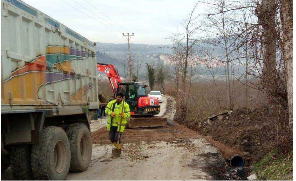
Hatıpli Mahallesi Kocacioğlu Sokak Korusu Boru İmalatı
