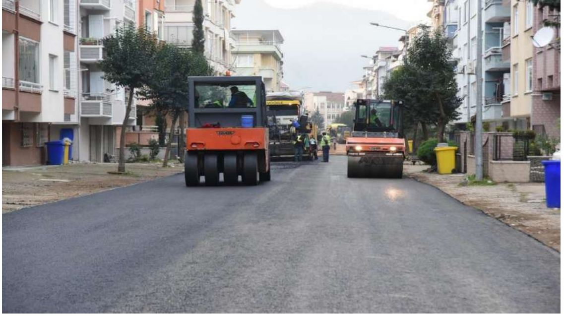
Bahçelievler Mahallesi Asfaltlama İşi İlk/Son Hali
