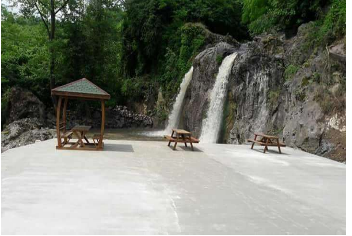
Yağmursuyu Hattı Çalışması
