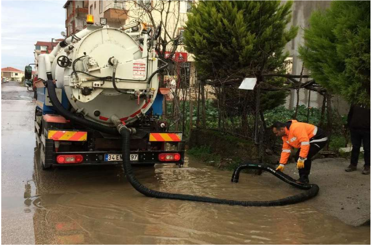
Vidanjör ile Yapılan Mazgal Açma İşlemi
