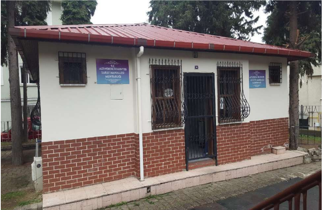
Karapınar Mahallesi Beton Laboratuvarı Yapım İşİ
