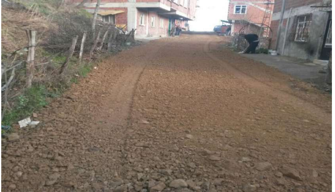
Yıldızlı Mahallesi Malzemeli Bakım Çalışması
