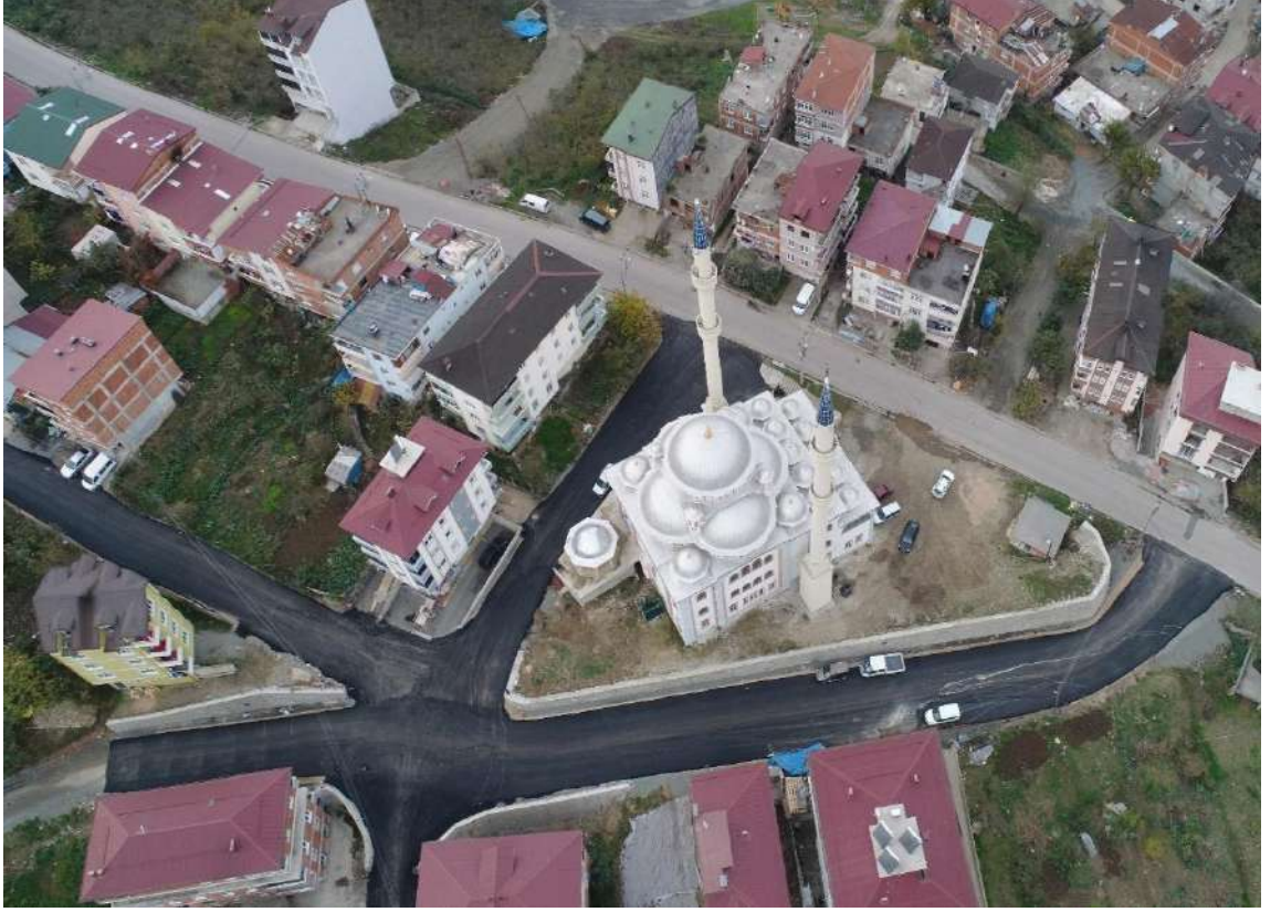
Karacaömer Mahallesi 1756, 1757 ve 1764 Nolu Sokaklar Asfaltlama İşi İlk/Son Hali
